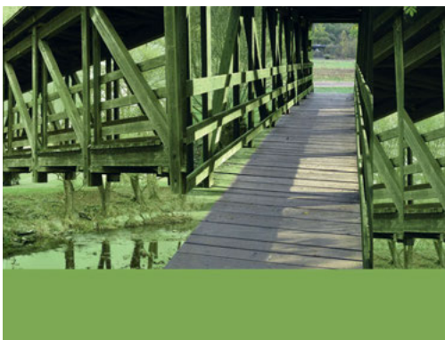
Lahnbrücke bei Wallau
